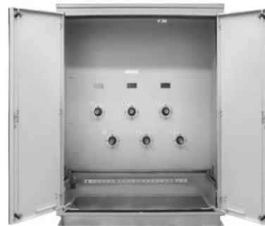
GMK-2000 KABELOVÝ VSTUP, HLAVNÍ UZEMŇOVACÍ PŘÍPOJNICE A VYSOKONAPĚŤOVÉ VÝVODY
