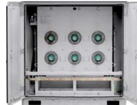
GMK-1000 KABELOVÝ VSTUP, HLAVNÍ UZEMŇOVACÍ PŘÍPOJNICE A VYSOKONAPĚŤOVÉ VÝVODY
