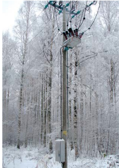
AUTOMATICKÝ RECLOSER OSM A OVLÁDACÍ A KOMUNIKAČNÍ SKŘÍŇ
